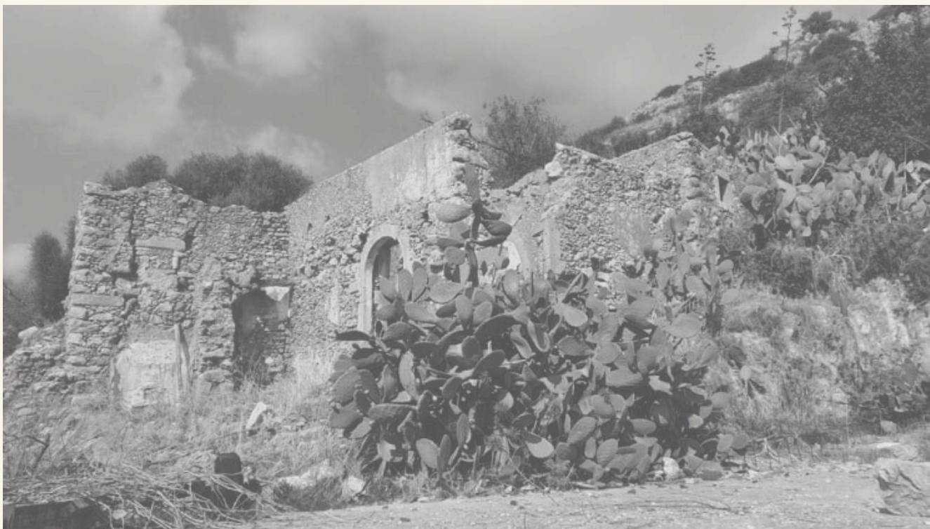
ΝΟΤΙΑ ΑΠΟΨΗ ΚΤΙΣΜΑΤΟΣ
